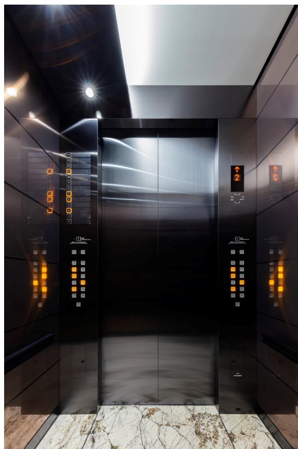
乗用エレベーターかご内
