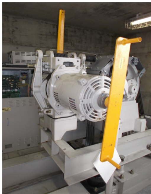
写真4 ブレーキ解放用器具を取り付けた状態
