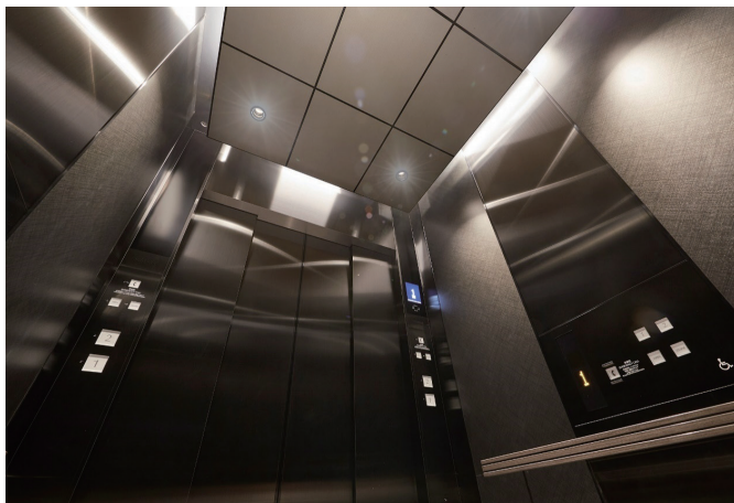
EV21号機 かご内
