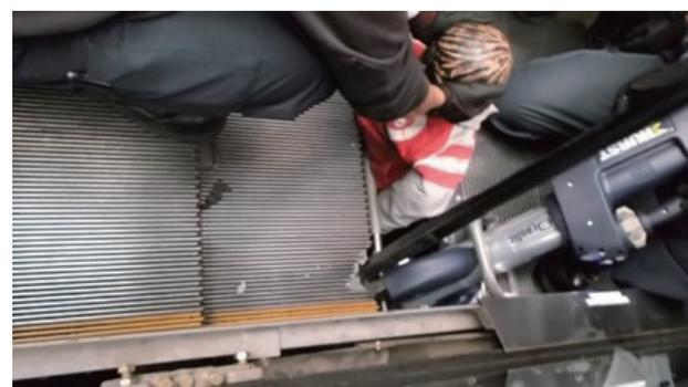
写真5 脱落したステップに転落（ひろげる）
