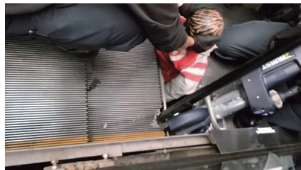
写真5 脱落したステップに転落（ひろげる）
