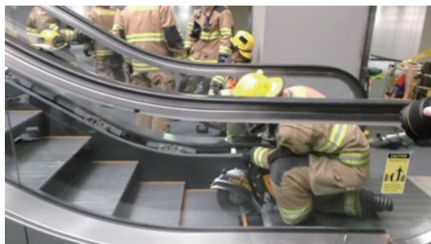
写真6 シャフトを切断（ぶっこわす）
