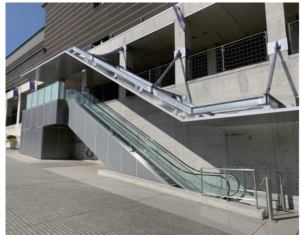
大ホールESC1号機 外観
