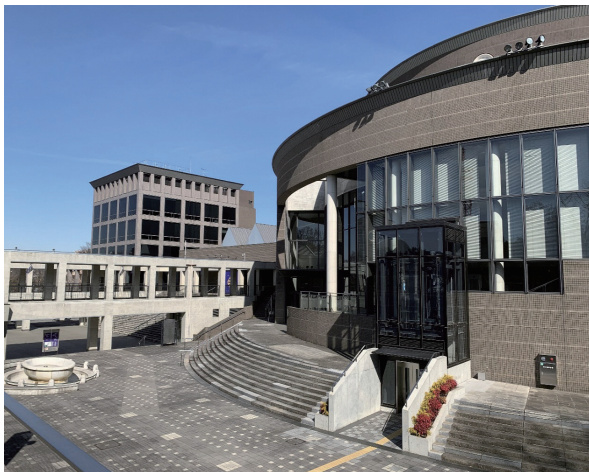
中ホール8号機 外観
