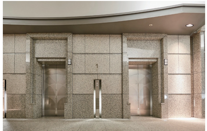
1階エントランス戸閉時 (左側号機：リニューアル前) (右側号機：リニューアル後) 【乗場用品既設流用】
