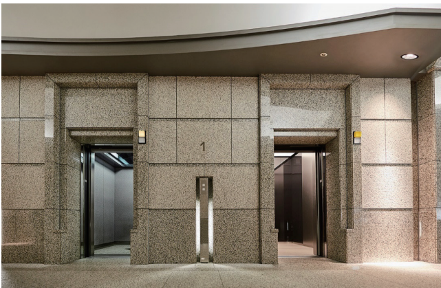
1階エントランス戸開時 (左側号機：リニューアル前) (右側号機：リニューアル後)
