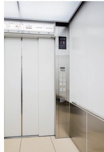
客用エレベーター 操作盤
