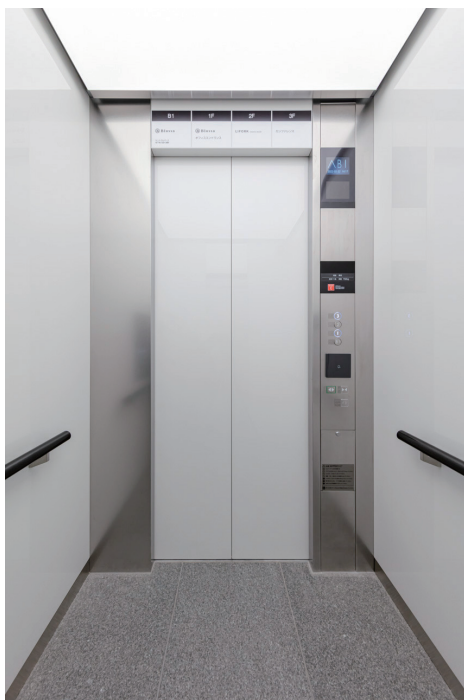
商業用エレベーター9、10号機 かご内
