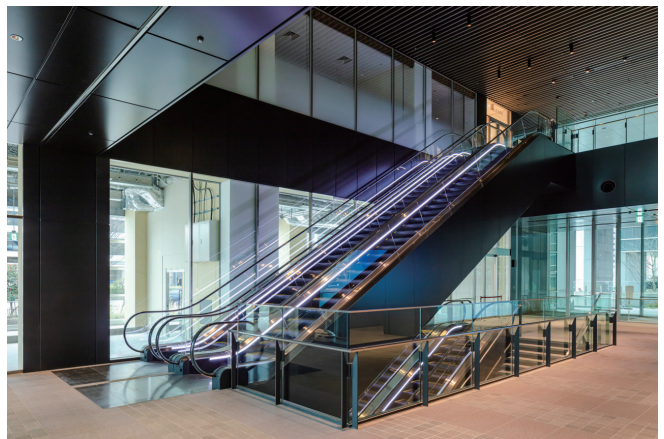
エスカレーター 1~4号機
