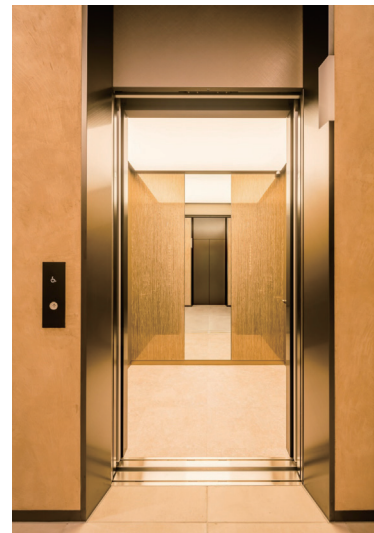
リニューアル後 L-1号機 かが内 (夜間)
