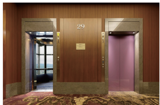
H-3、4号機 29階出入口 (H-4戸開)
