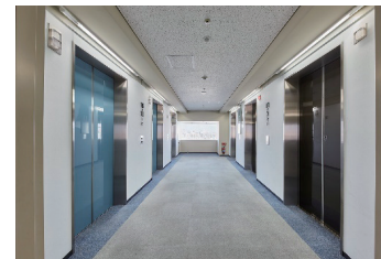
1～6号機 中間階 エレベーターホール (左側：リニューアル前 右側：リニューアル後)
