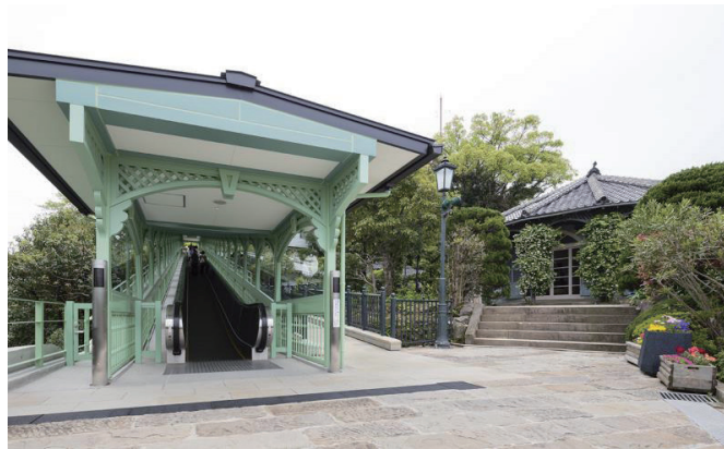
動く歩道乗降口（1号機）（左）と旧グラバー住宅（右）
