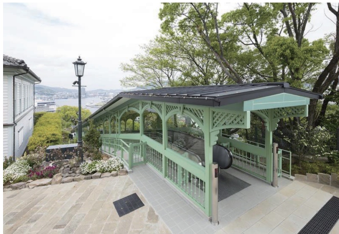
動く歩道外観（1号機）
