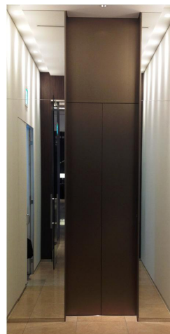
ウエディング用 エレベーター乗場
