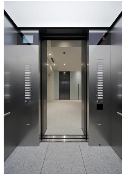
高層用エレベーターかご内
