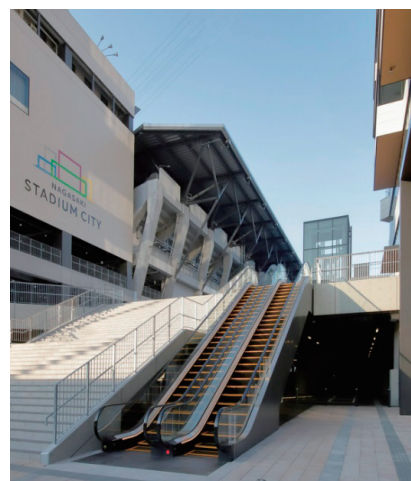
コンコース エスカレーター1、2号機外観
