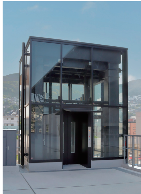
コンコース 9号機3階エレベーター正面
