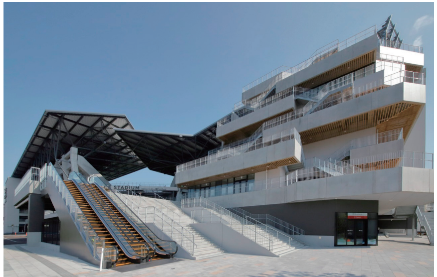
スタジアム エスカレーター5、6号機外観
