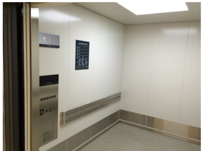
寝台用エレベーターかご内 2
