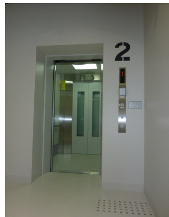
エレベーター No.3 : EV-T3-06H (2階)
