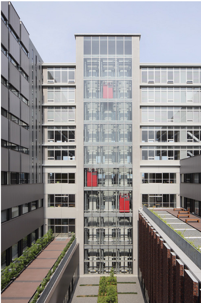
ガラスシャフトエレベーター 外観
