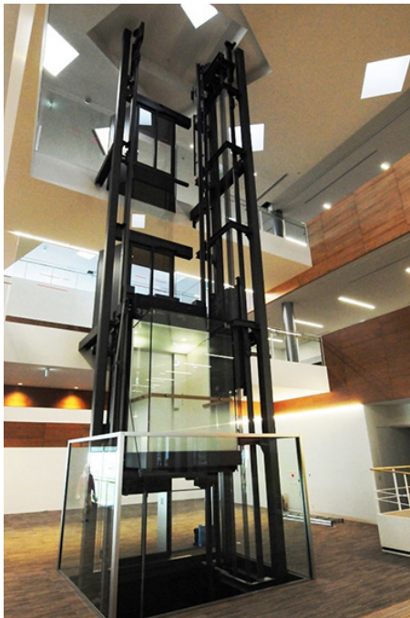
展望エレベーター昇降路
