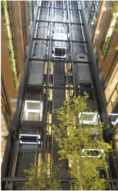
展望用エレベーター昇降路
