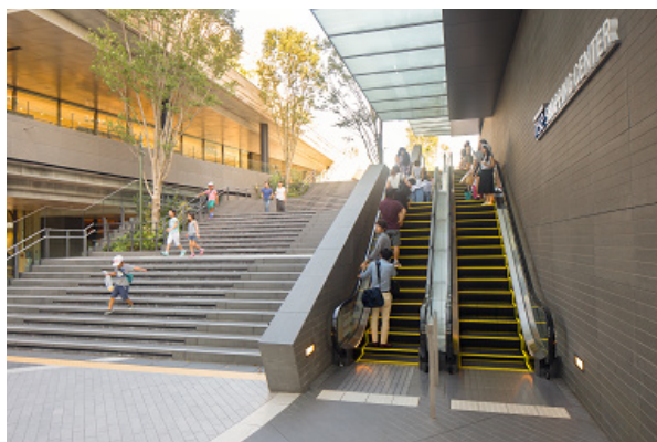
低層棟 リボンストリート L-E1～4号機エスカレーター
