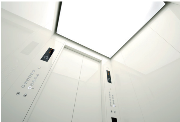
WESTRIO3 エレベーター内部
