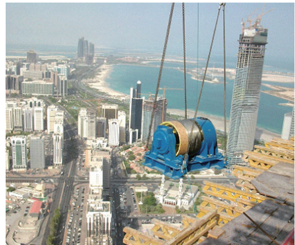
エレベーター巻上機 搬入風景
